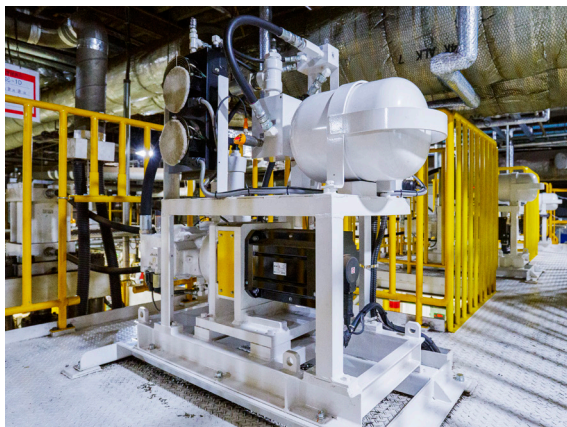
ポンプ容量80cm 3 と140cm 3 の「エコサーボ」と密閉加圧タンクなどを一体化したパッケージユニットを導入
